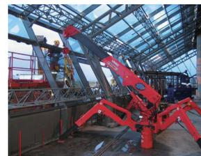
履带式液压起重机为新时代最新科技产品，可免除液压吊车需要占用运输用卡车问题，可在工地自行移动位置，甚至可以进入狭小空间进行室内起重作业，使施工变得更为方便和可行！
